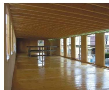
◀ Vue de l'étage en cours de chantier : la dalle bois sert de support aux panneaux de bois massif porteurs et au solivage du toit.
