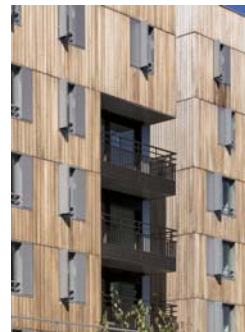
▲ Des loggias génèrent des failles dans les façades.
