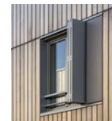
▲ Bavettes et volets coulissants sont placés au nu extérieur.
