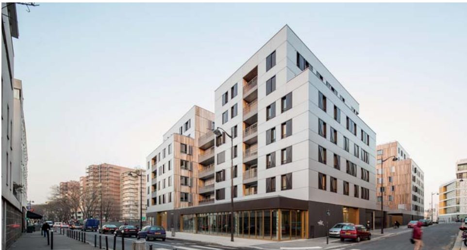
▲ Les quatre plots de logements et le socle du rez-de-chaussée (accueillant une crèche, un local associatif et le premier supermarché coopératif de Paris) reconstituent le front urbain de l'îlot.
