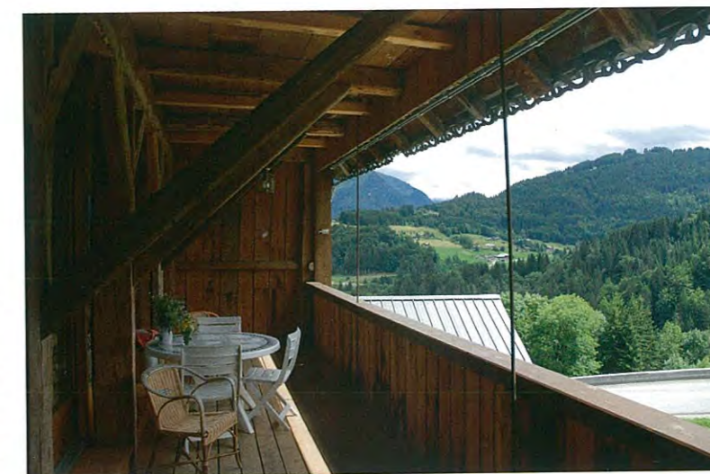
Rénovation partielle d'une ancienne grange en Haute-Savoie. Un grand balcon a été aménagé sur la largeur du bâtiment, procurant un espace extérieur très protégé. Les volets coulissent pour ouvrir sur la nature. Fermés, ils restituent au bâtiment son aspect d'origine.
