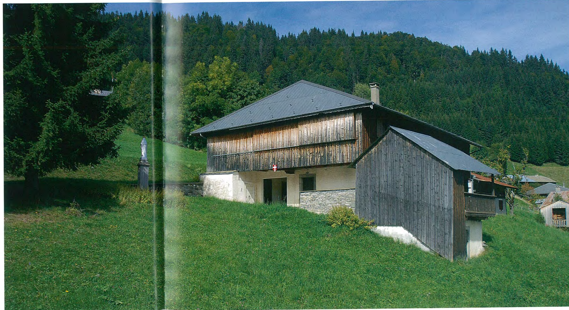
Rénovation partielle d'une ancienne grange en Haute-Savoie. Un grand balcon a été aménagé sur la largeur du bâtiment, procurant un espace extérieur très protégé. Les volets coulissent pour ouvrir sur la nature. Fermés, ils restituent au bâtiment son aspect d'origine.
