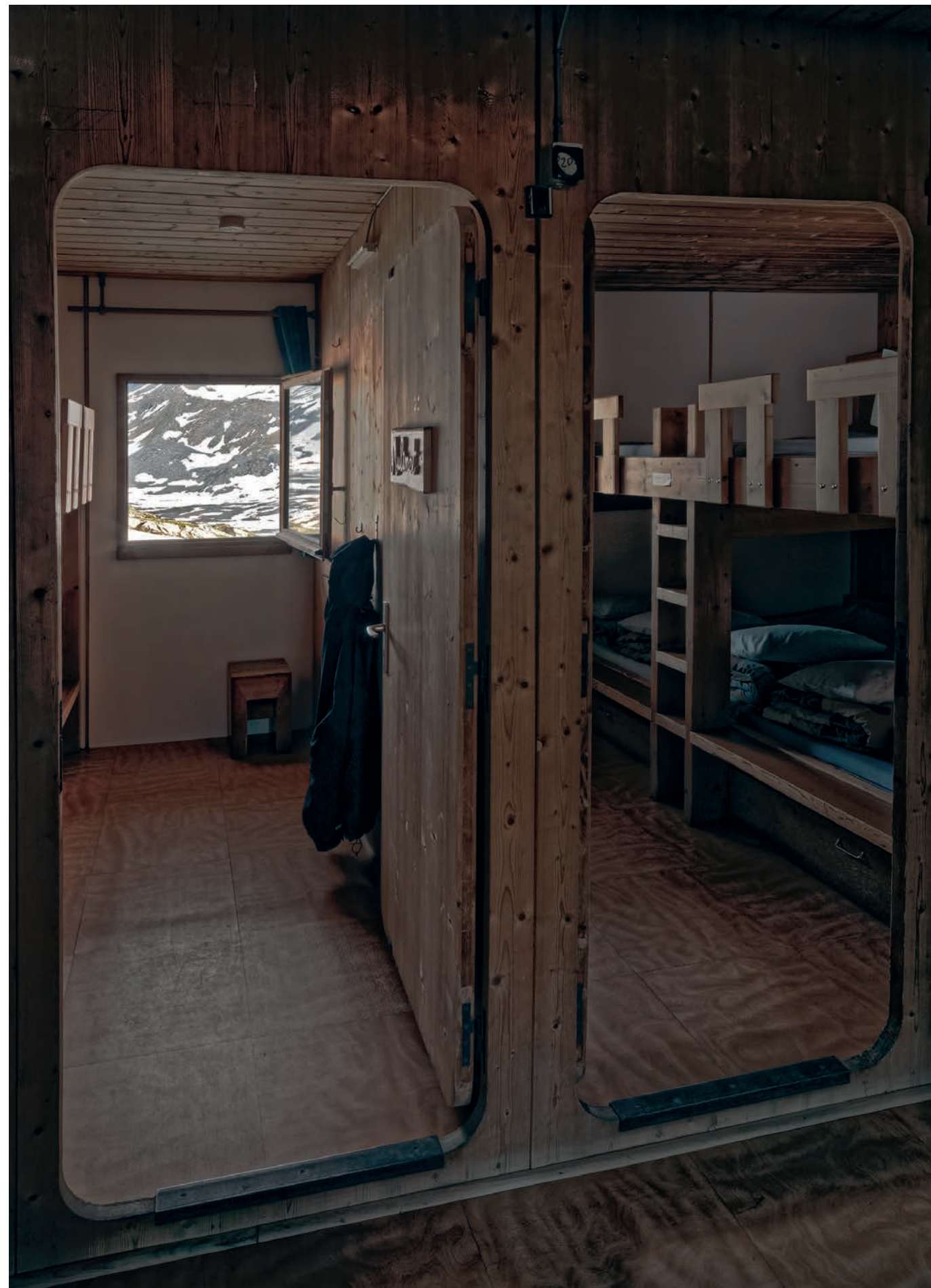
15- Dortoirs équipés de 10 couchettes disposées en bat-flanc, cloisonnés par des panneaux de bois contrecollés « Rousseau » dans lesquels les portes ont été découpées et fixées sans huisserie. Photo Franck Trabouillet© Région Auvergne-Rhône-Alpes, Inventaire général du patrimoine culturel, 2018
