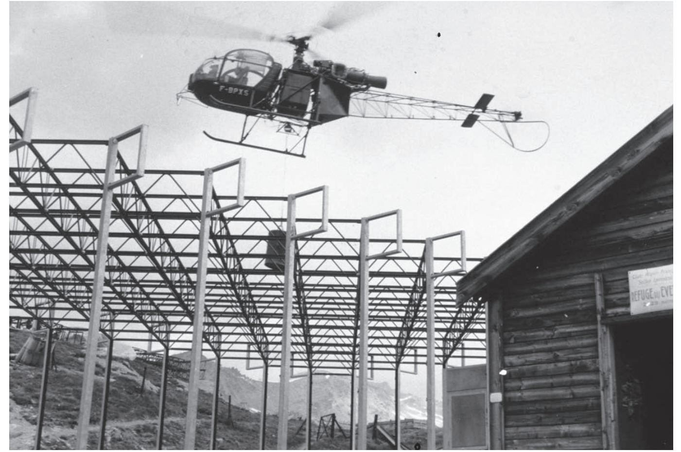
7- Charpente aluminium en cours d'assemblage sur le chantier du refuge des Évettes © AAM-Guy Rey-Millet.
