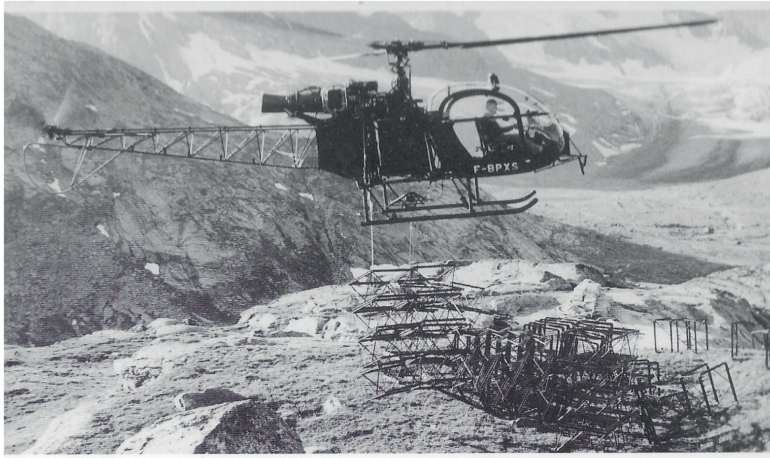
6- Acheminement par hélicoptère des modules tridimensionnels sur le chantier. ©Jean Masson, extrait de Peter Sulzer, Jean Prouvé, œuvre complète, volume4 :1954-1984, Birkhäuser éditeur 2008, p243
