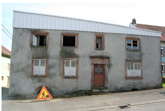
Figure 4 Maison Koeppel, façade nord.
