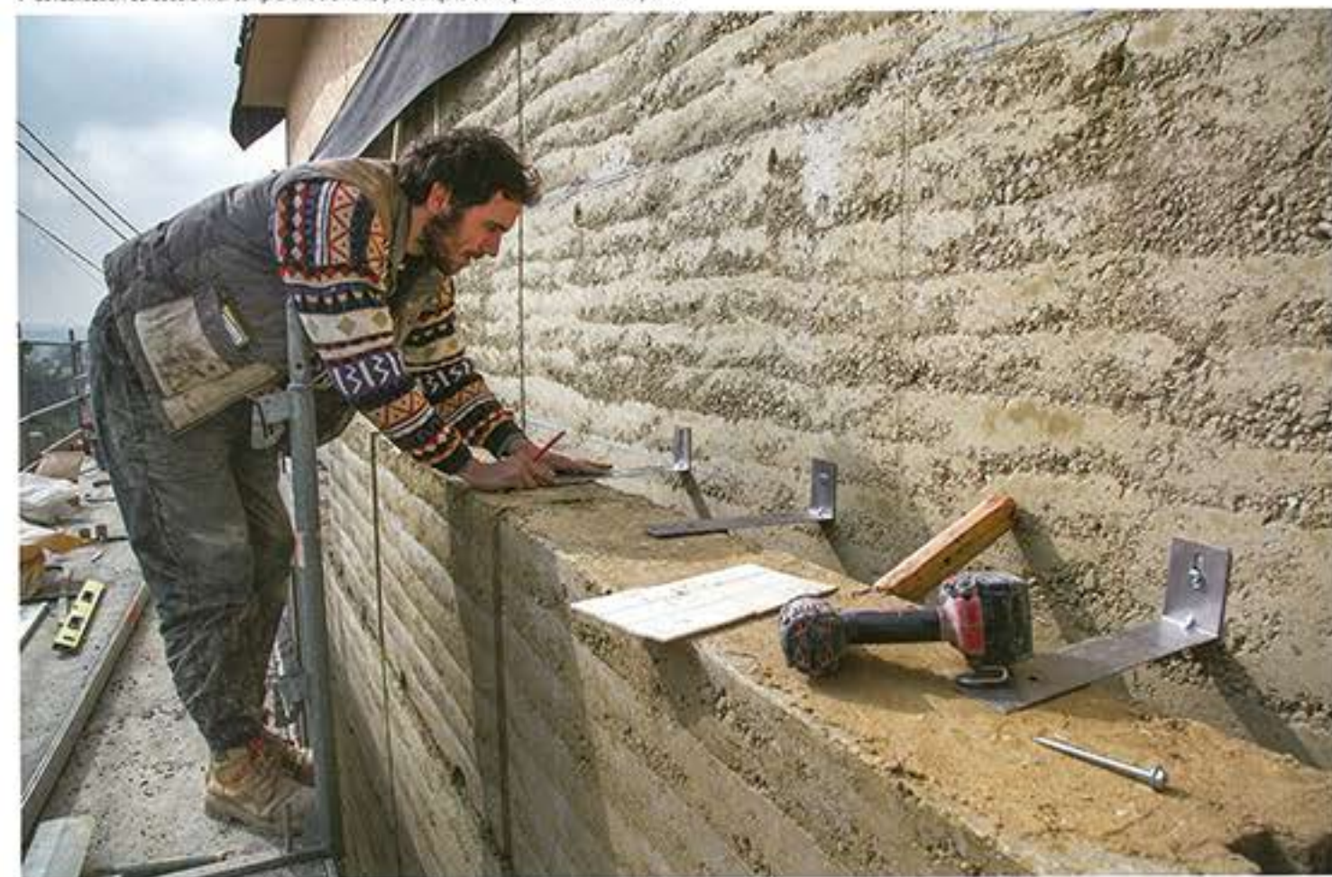
A Vue de détail : les strates du mur reflètent les phases de compactage de la terre. Le temps du chantier se lit directement sur la paroi (à gauche). Mise en place des blocs préfabriqués (à droite). V Solidarisation du double mur comprenant éléments préfabriqués et maçonnerie coulée en place.
