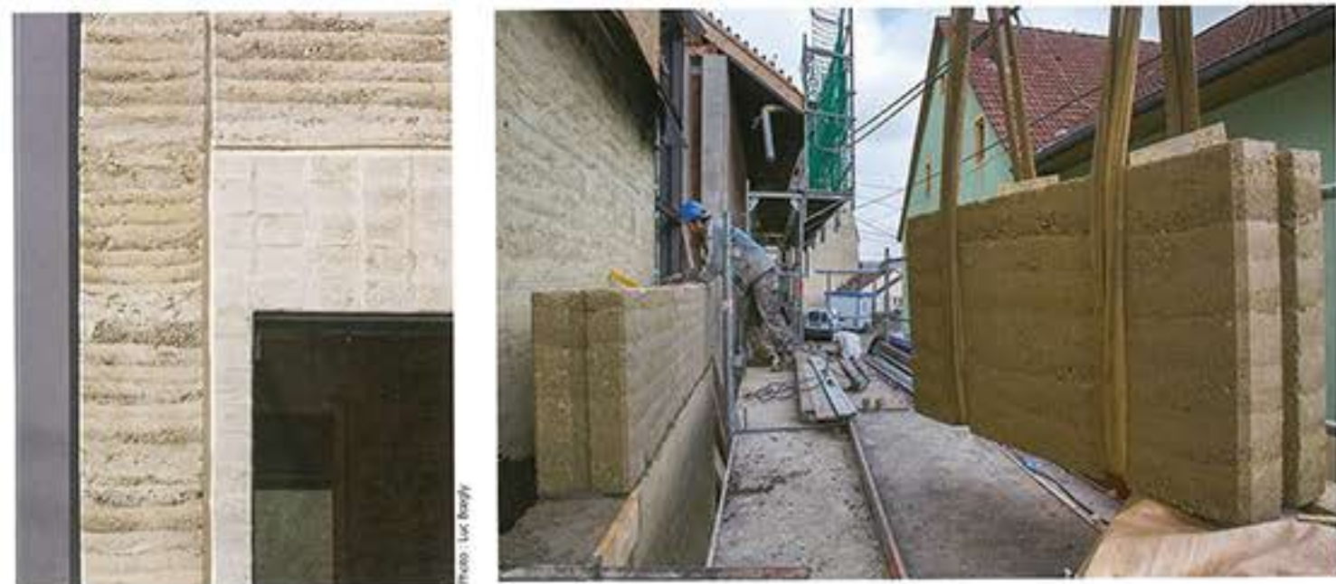
A Vue de détail : les strates du mur reflètent les phases de compactage de la terre. Le temps du chantier se lit directement sur la paroi (à gauche). Mise en place des blocs préfabriqués (à droite). V Solidarisation du double mur comprenant éléments préfabriqués et maçonnerie coulée en place.
