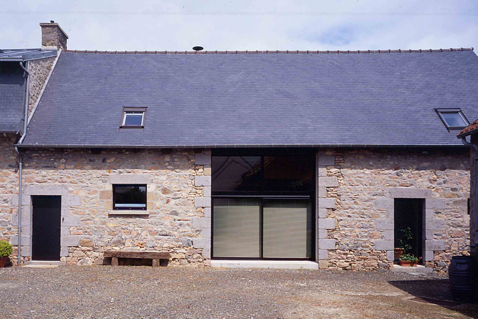
Le coffre du volet roulant est logé dans le mur. Ainsi, de l'extérieur, il ne dénature pas la façade. Les menuiseries sont en aluminium anodisé noir.
