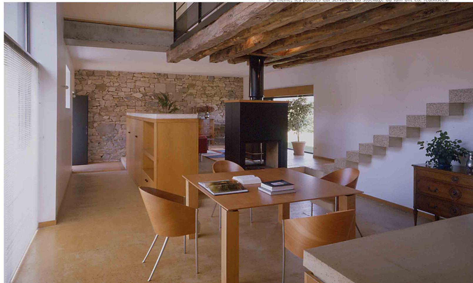
Le mur existant en granit et schiste tout venant a été conservé et sablé. Une petite rigole au pied du mur récupère le sable des joints. De même, les poutres qui servaient au stockage du foin ont été réutilisées.
