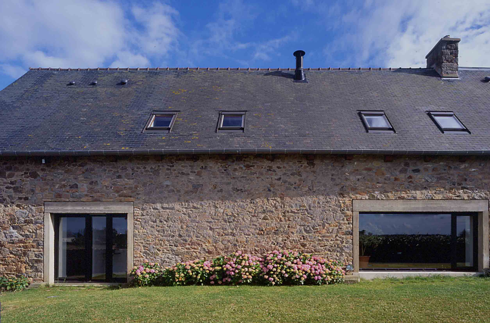
Au nord, la façade a été retravaillée pour profiter pleinement de la vue sur le jardin.
